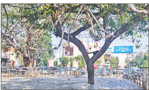
सोनीपत। मॉडल टाउन के टाकुर द्वार चौक पर पेड़ के चारों ओर कंक्रीट डालकर बनाया गया चबूतरा, लगाई गई ग़िल।
